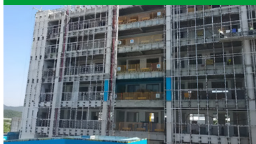
Curtain Wall Steel Keel System 幕墙钢龙骨体系
