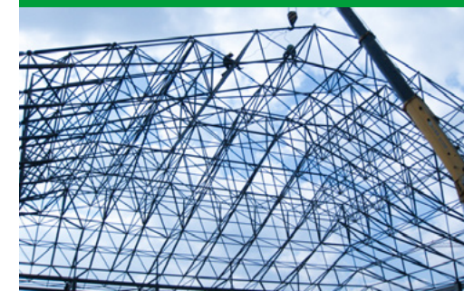
Grid Structure 网架
